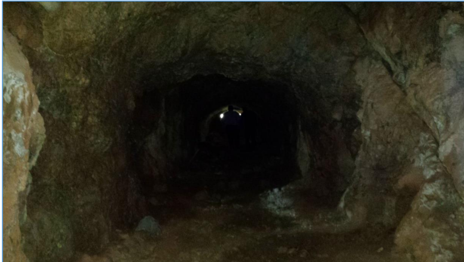
Slika 14 - Unutrašnjost rudarskog okna s manjom preprekom rastresitog materijala
